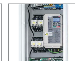
Quadro di manovra Impianto Mrl
